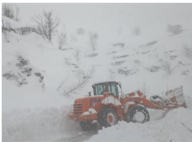
Lavori per la slavina nella strada di Balze e in alto la slavina ai Mandrioli
